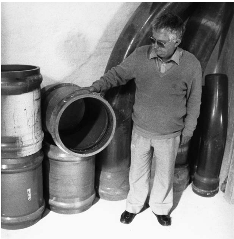
Mogens Lüth på lageret i vandtårnet med 400 mm skydemuffer til reparation af vandforsyningens største vandledninger. 1988.
