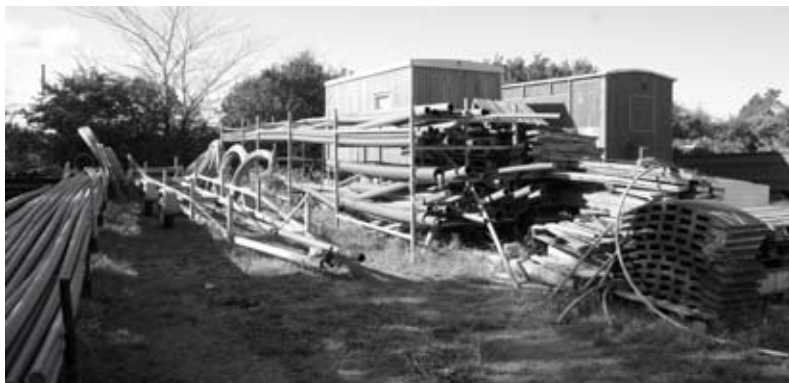
Rørdepot i industrikvarteret (Tigervej). 2006.
